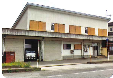
津川学校給食センター
